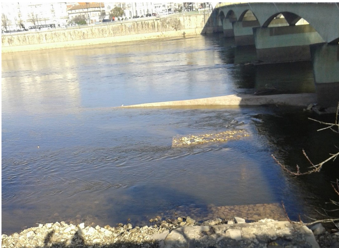
Figura 4 – Pilares da antiga ponte de pedra, junto à Ponte de Santa Clara.
