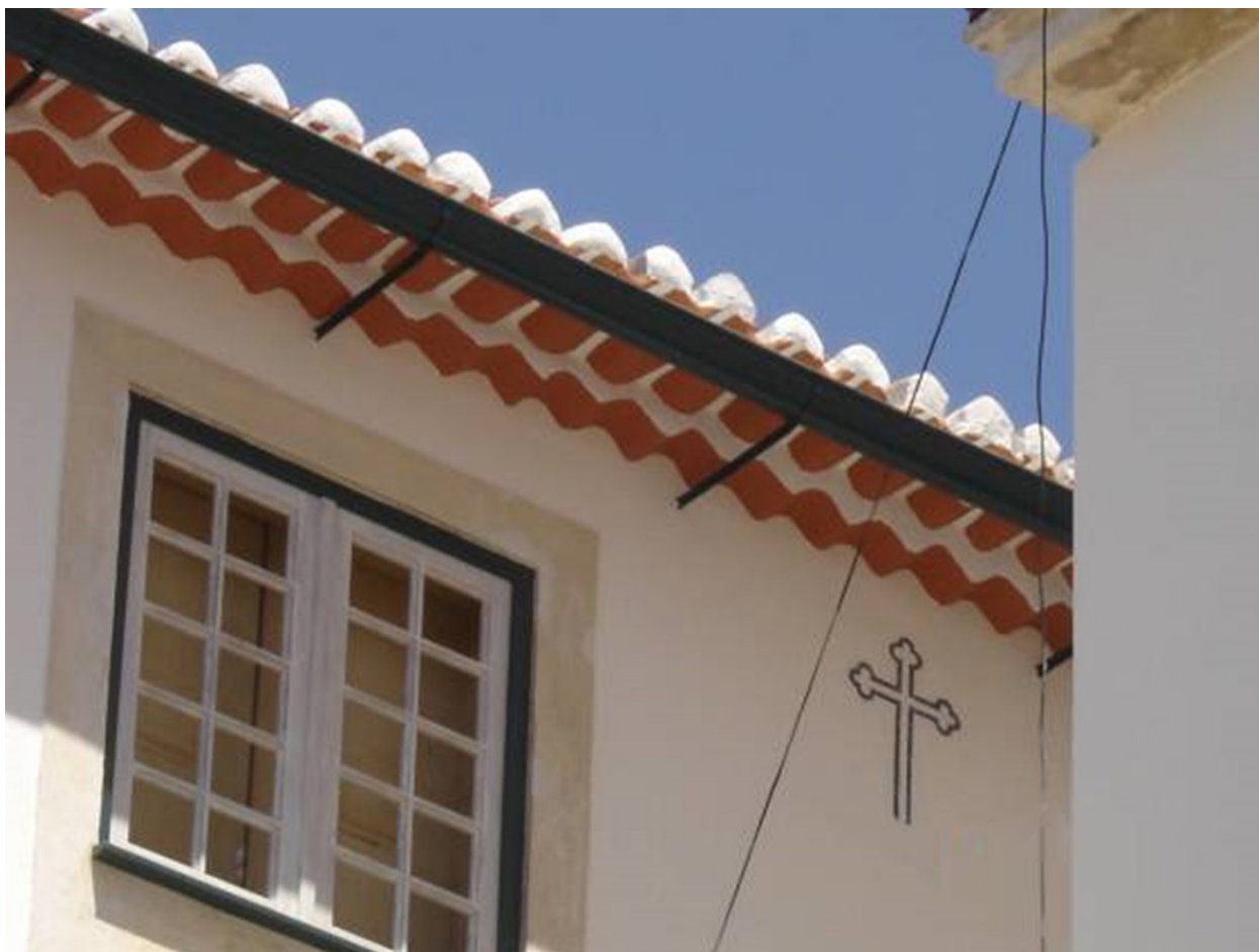
Figura 9 – Perspetiva da cruz patente na fachada sul do imóvel sito na Rua Joaquim António de Aguiar n.ºs 30-40 / Escadas de S. Cristóvão n.ºs 1-5.
