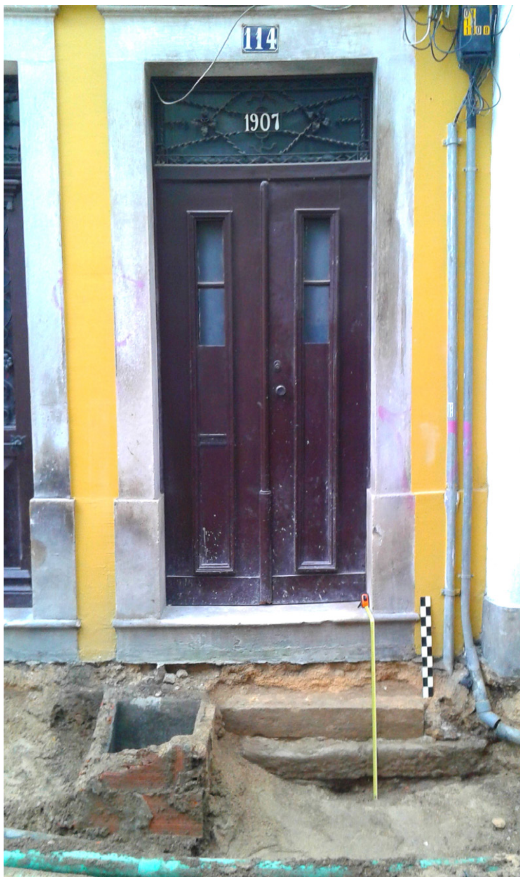
Figura 8 – Fachada do imóvel sito no número 114 da Rua Joaquim Antônio de Aguiar, com referência ao ano de 1907 na bandeira da porta; os antigos degraus postos a descoberto aquando de mais uma intervenção, hoje abaixo da cota atual da rua, são testemunho do alteamento desta artéria (+- 60 cm) em função das várias infraestruturas aí instaladas ao longo do século XX e XXI.
