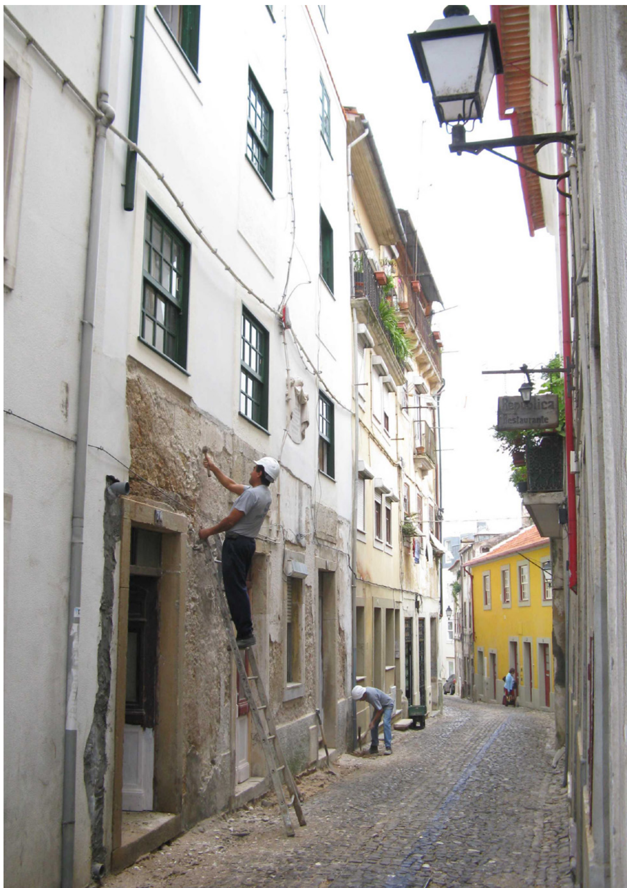
Figura 2 – Picagem dos rebocos da fachada do imóvel sito na Rua Joaquim António de Aguiar n.º 66-70 e peça de cantaria posta em evidência com epígrafe referente à Confraria da Sé.
