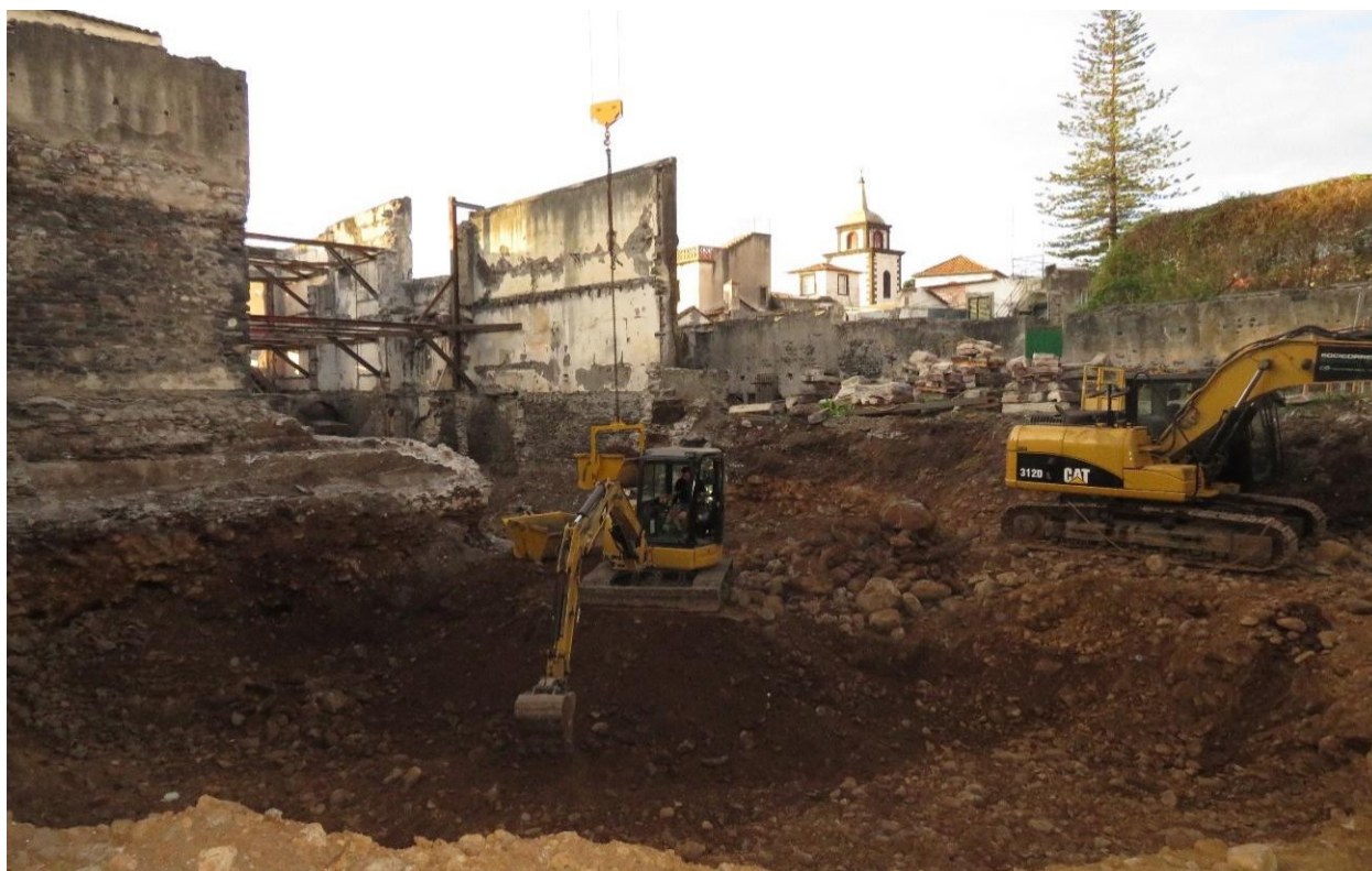
Figura 8 – Trabalhos arqueológicos na Antiga Fábrica de Bordados, Funchal (Rua de S. Pedro, nº23, 25 e 27, Funchal). Orientação NE-SO.
