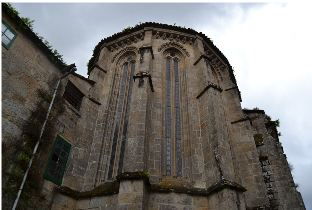
Figura 4 – Abside da igreja do Convento de Santa Clara, Pontevedra.
