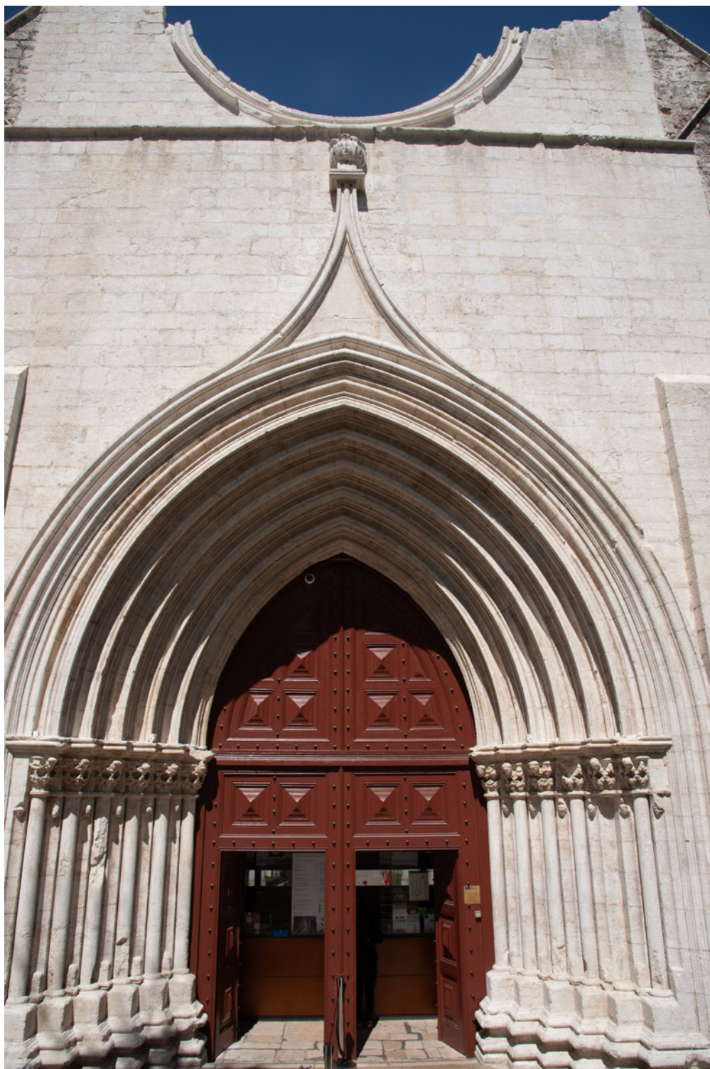
Figura 2 – Fachada ocidental e portal de entrada da Igreja do Carmo de Lisboa. Fotografia: Célia Nunes Pereira, 2023.
