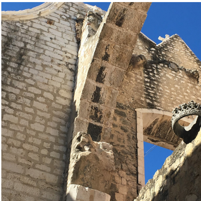
Figura 6 – Vestígios das antigas abóbadas da nave norte da Igreja do Carmo de Lisboa. Fotografia: Célia Nunes Pereira, 2023.
