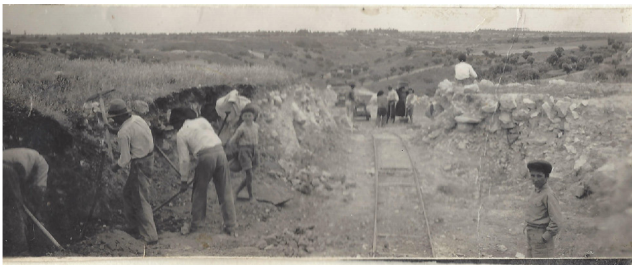
Figura 2 – Aspecto da escavação no reduto central – década de 1940 (imagem cedida por José Inácio, a criança à esquerda na foto).
