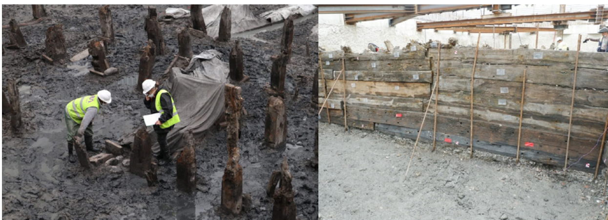
Figura 8 - Vistas de sistemas de estacaria onde é visível o aproveitamento de elementos de antigas embarcações (EDP e Av. 24 de Julho).
