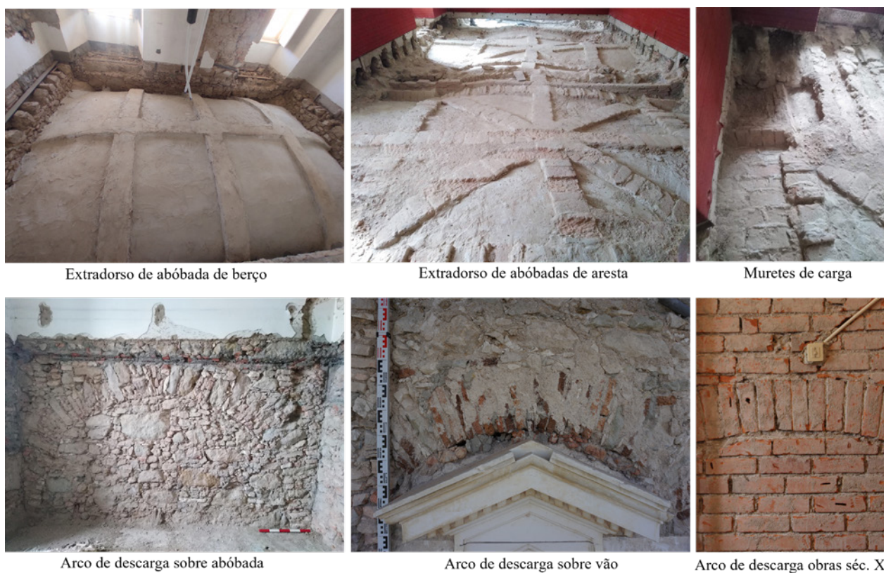
Figura 3 – Técnicas construtivas identificadas no decurso da intervenção realizada no âmbito das obras de reabilitação do espaço do Seminário Maior de Coimbra.
