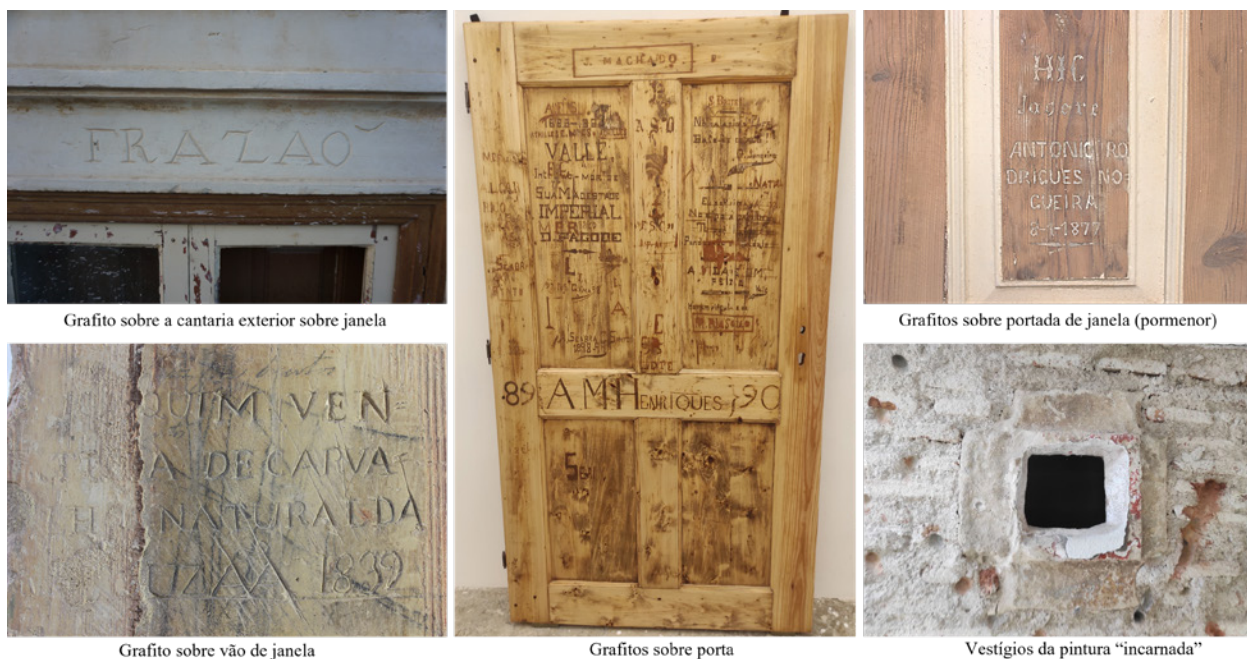
Figura 5 – Grafitos sobre suporte pétreo e sobre madeira e vestígios da pintura “incarnada” original identificados no decurso da intervenção realizada no âmbito das obras de reabilitação do espaço do Seminário Maior de Coimbra (alguns exemplos).
