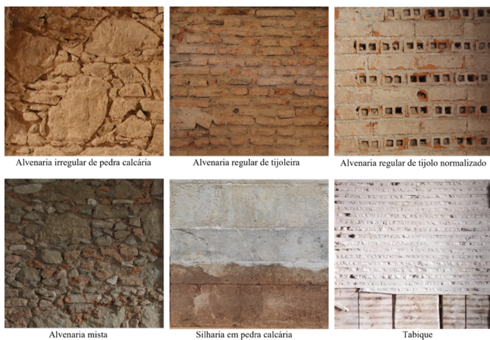
Figura 2 – Tipologias de construção identificadas no decurso da intervenção realizada no âmbito das obras de reabilitação do espaço do Seminário Maior de Coimbra.
