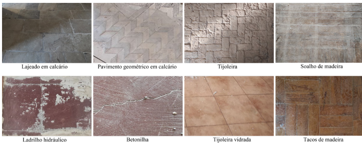
Figura 4 – Tipos de pavimento identificados no decurso da intervenção realizada no âmbito das obras de reabilitação do espaço do Seminário Maior de Coimbra.
