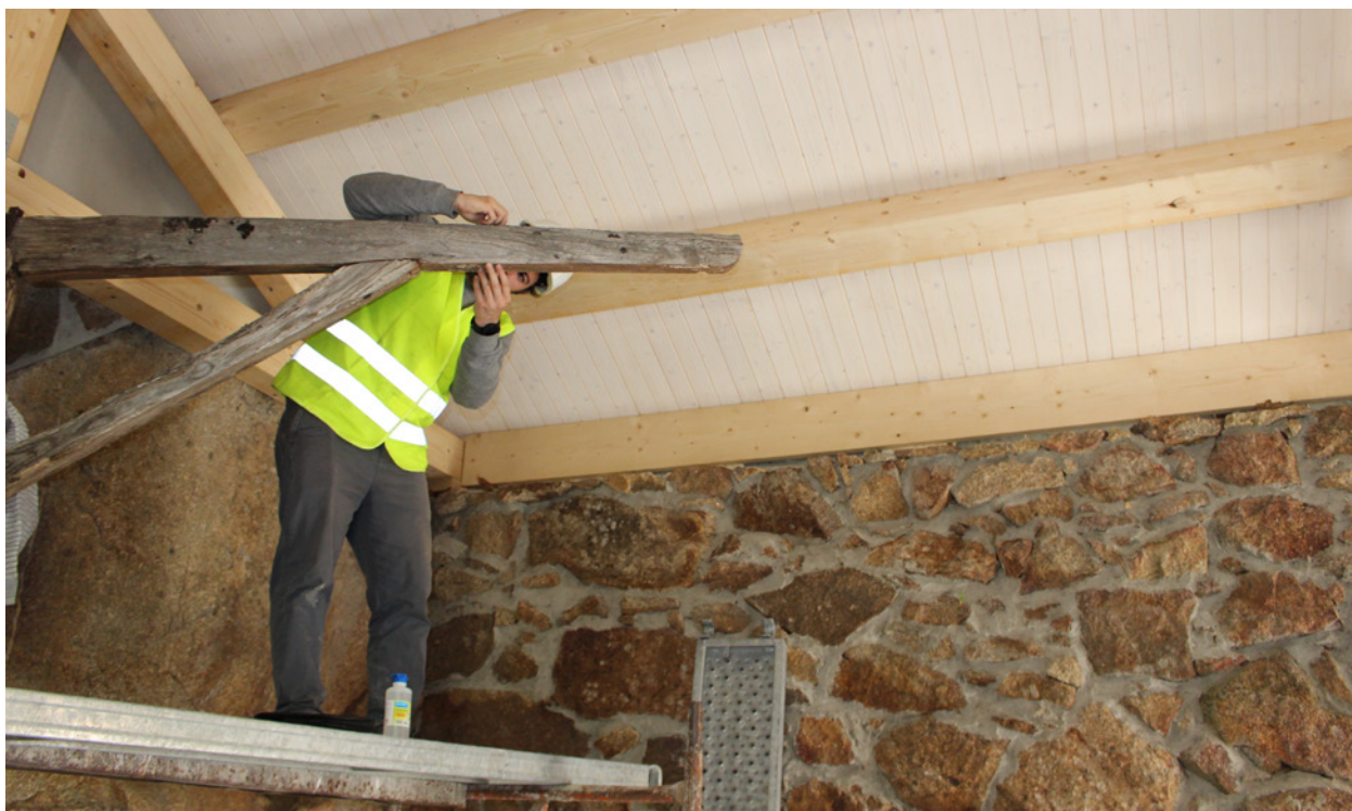
Figura 8 – Limpeza inicial de uma estrutura em madeira.
