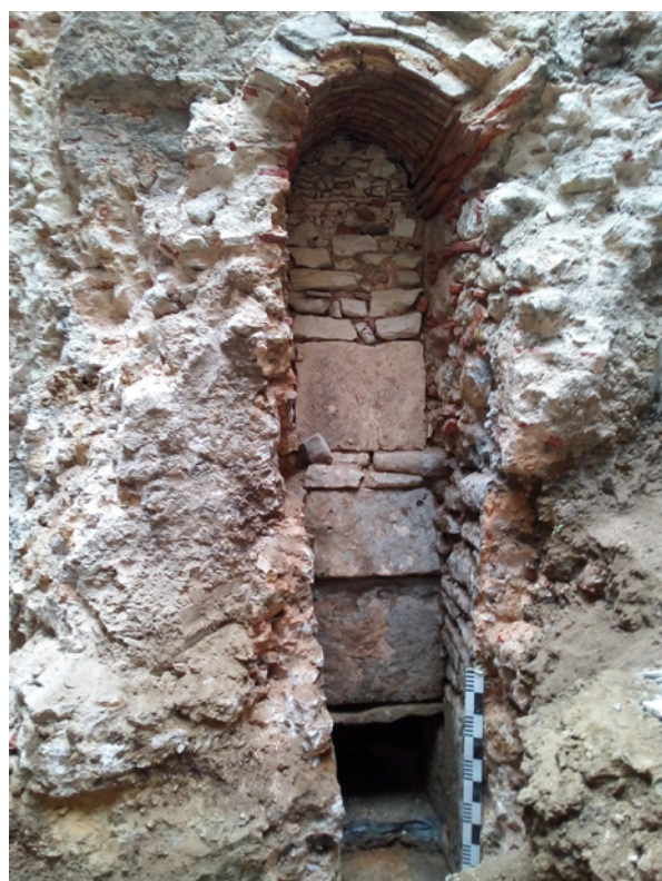
Figura 7 – Término com uma queda de 3,60m do caneiro na fachada tardoz.
