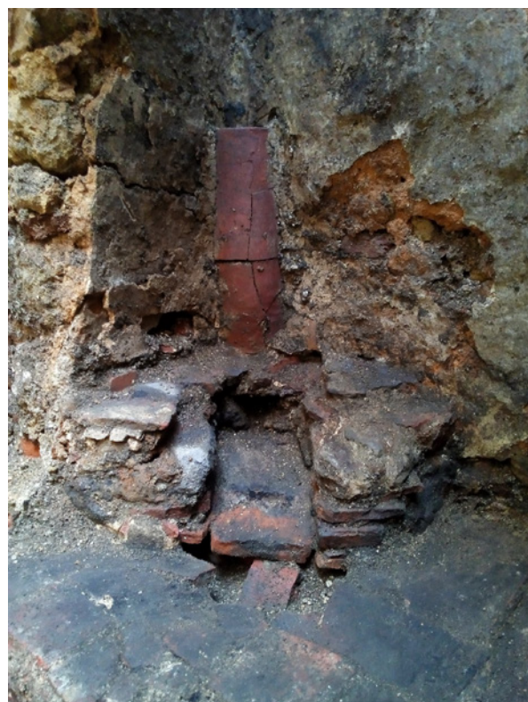
Figura 3 – Fogão no interior da lareira.
