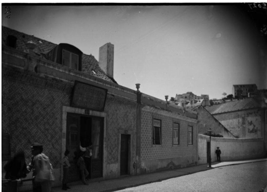
Figura 8 – Foto de Machado & Souza de 1900 da fachada do nº 61, onde também é visível o muro do logradouro (fonte: Arquivo Municipal de Lisboa).
