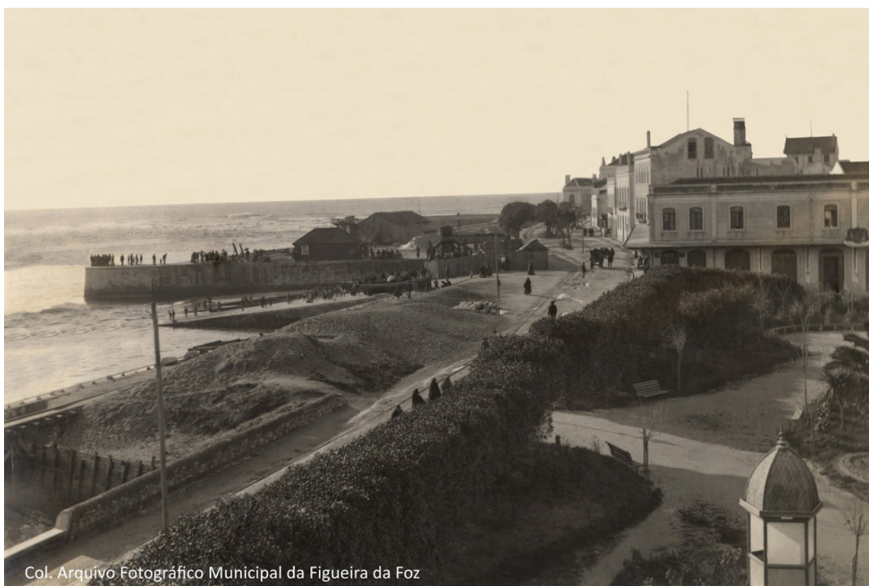
Imagem 6 – Captura dos trabalhos de construção do paredão ribeirinho. Fotografia de autor desconhecido.
