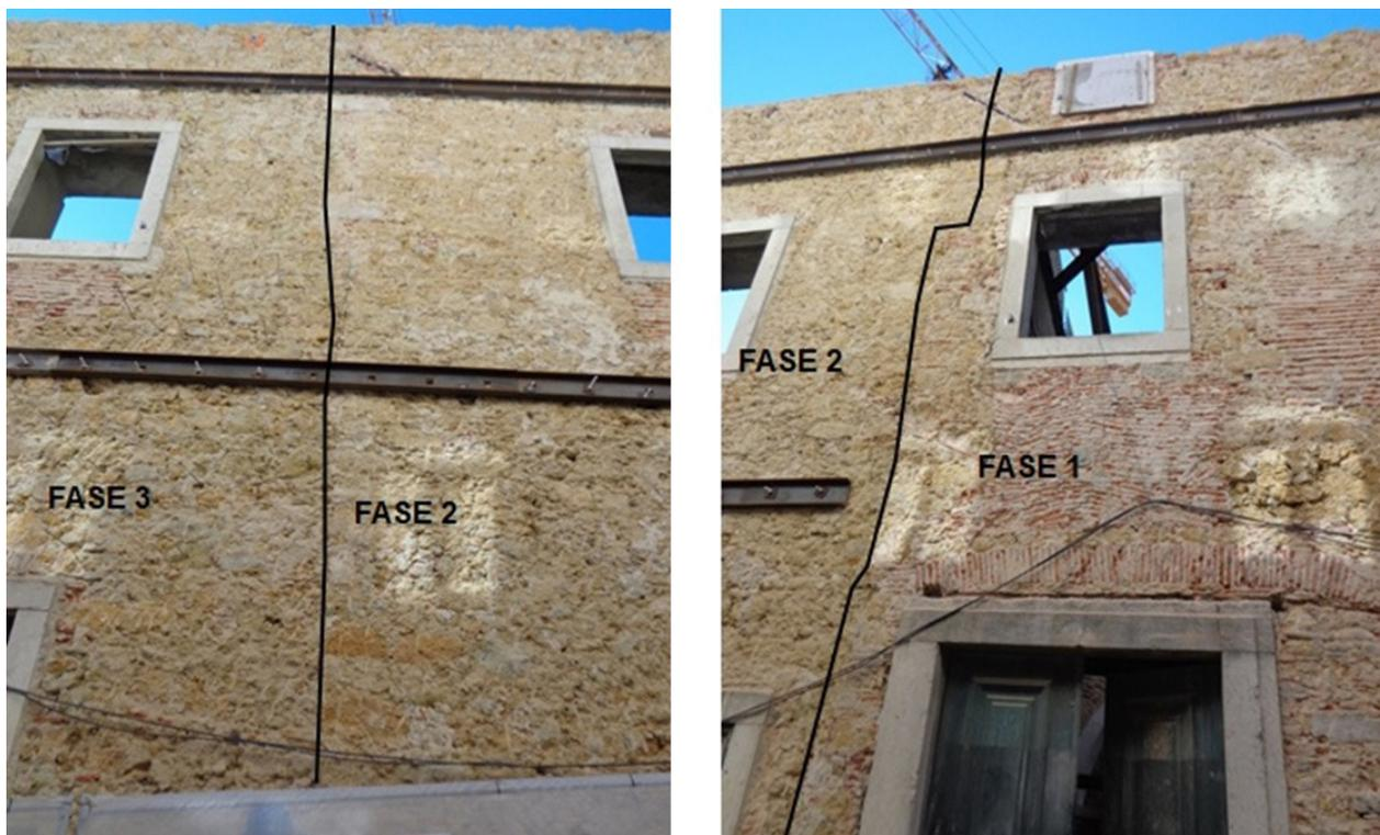
Figura 6 – Aspecto da fachada exterior voltada à Travessa José Vaz de Carvalho podendo observar-se a distinção entre Fase 1 e Fase 2 e entre Fase 2 e Fase 3.
