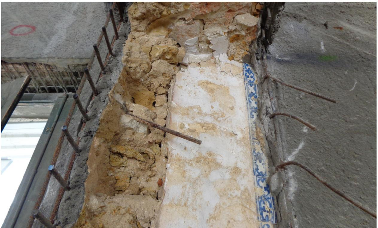
Figura 8 - Parede 5: aspecto da recuperação de uma porta que havia sido entaipada, integrando azulejo de cantoneira no revestimento interno.
