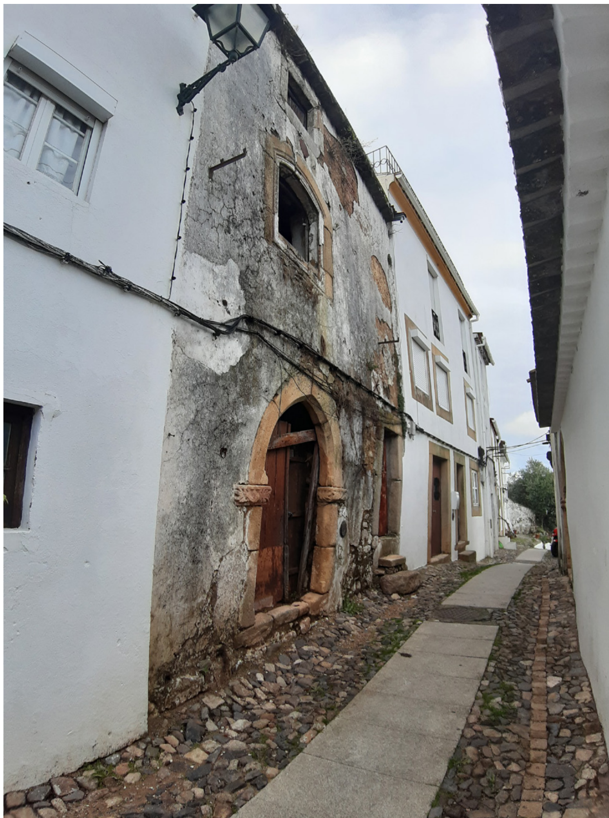
Figura 3 – Aspeto geral da fachada do edifício alvo de intervenção.
