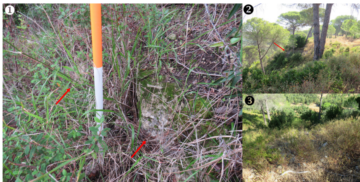
Figura 6 – 1. Troços de uma possível torre; 2. Vista geral da encosta Norte do cerro onde se implanta a provável estrutura defensiva; 3. Derrubes de silhares de pedras junto à torre.
