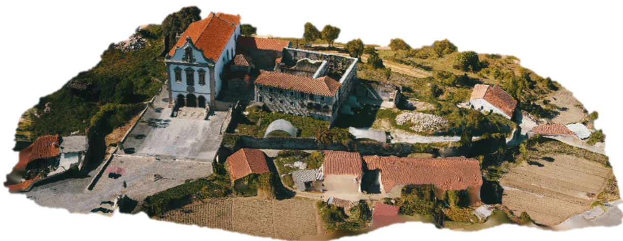
Figura 1– Modelo 3D do convento de S. Francisco de Real, durante os trabalhos de recuperação que estão a decorrer. © UAUM/ Francisco Andrade (base fotográfica Paulo Bernardes).
