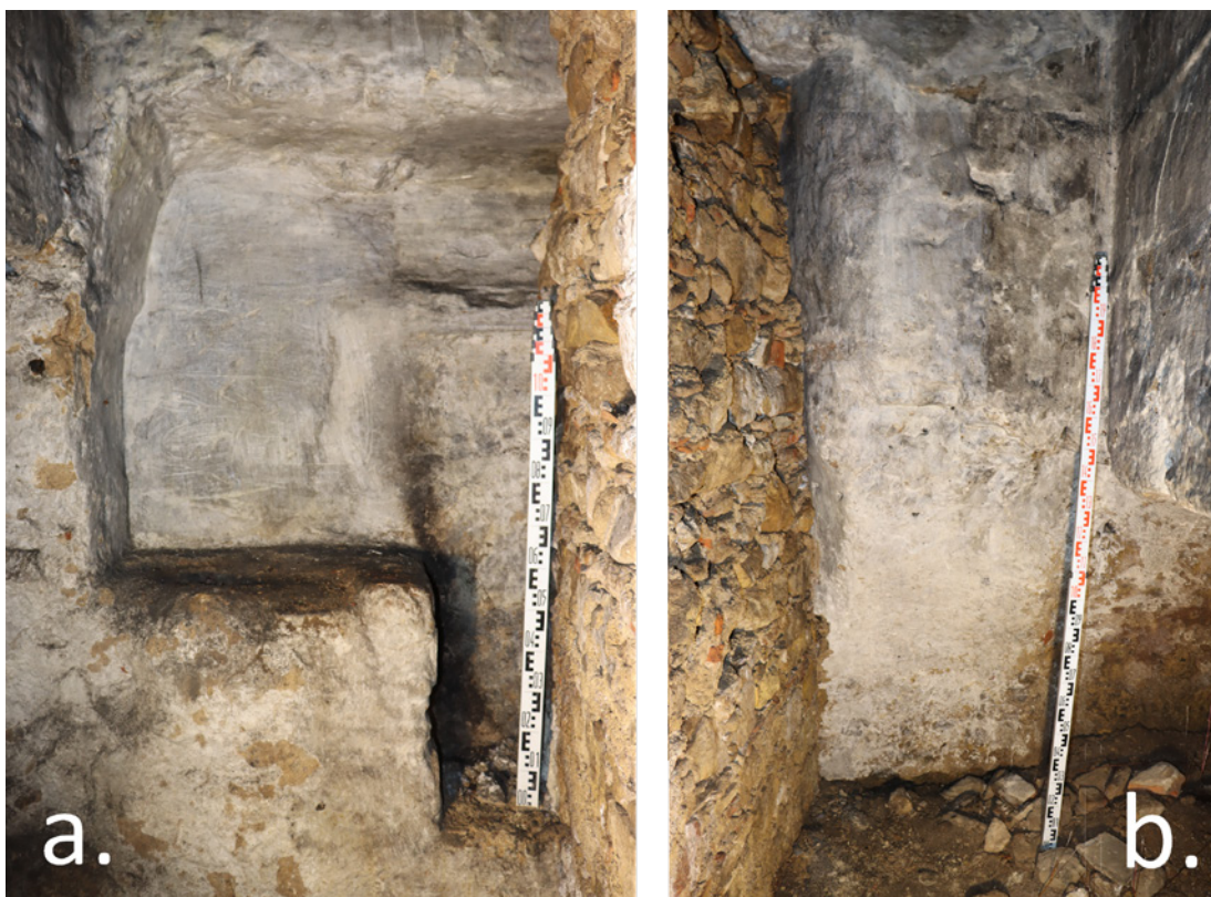
Figura 7 – “Galeria” subterrânea: a. Entalhes empena Este; b. entalhes empena Oeste.
