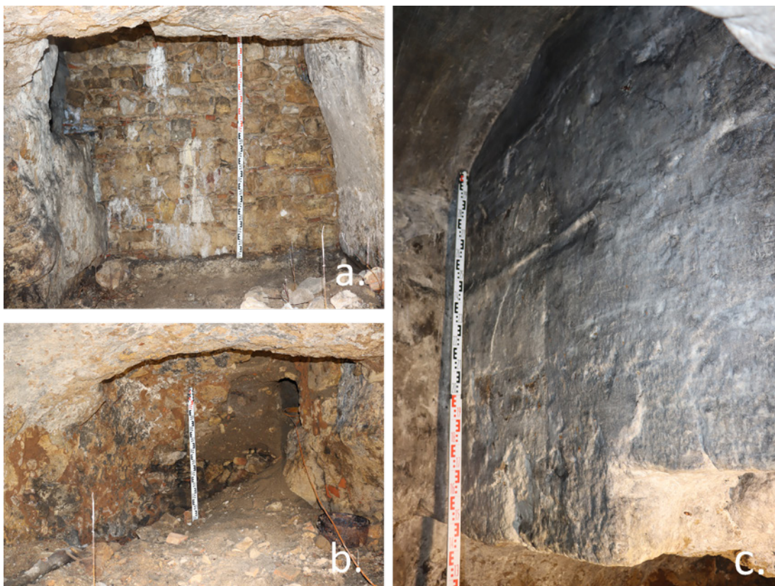
Figura 6 – “Galeria” subterrânea: a. Acesso e parede meeira; b. Muro de sustentação da escadaria de acesso à câmara da vereação; c. Parede sul da torre de Almedina.
