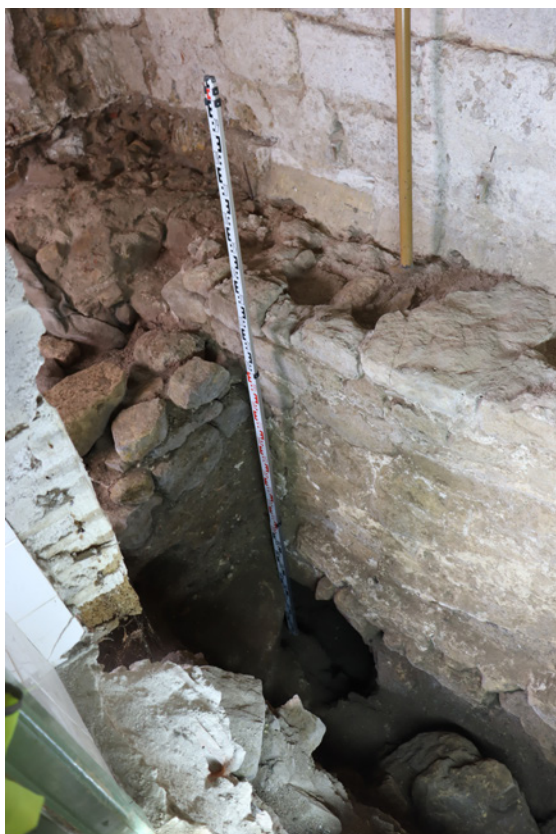
Figura 4 – Alçado da base da torre com o acesso à “galeria” subterrânea.
