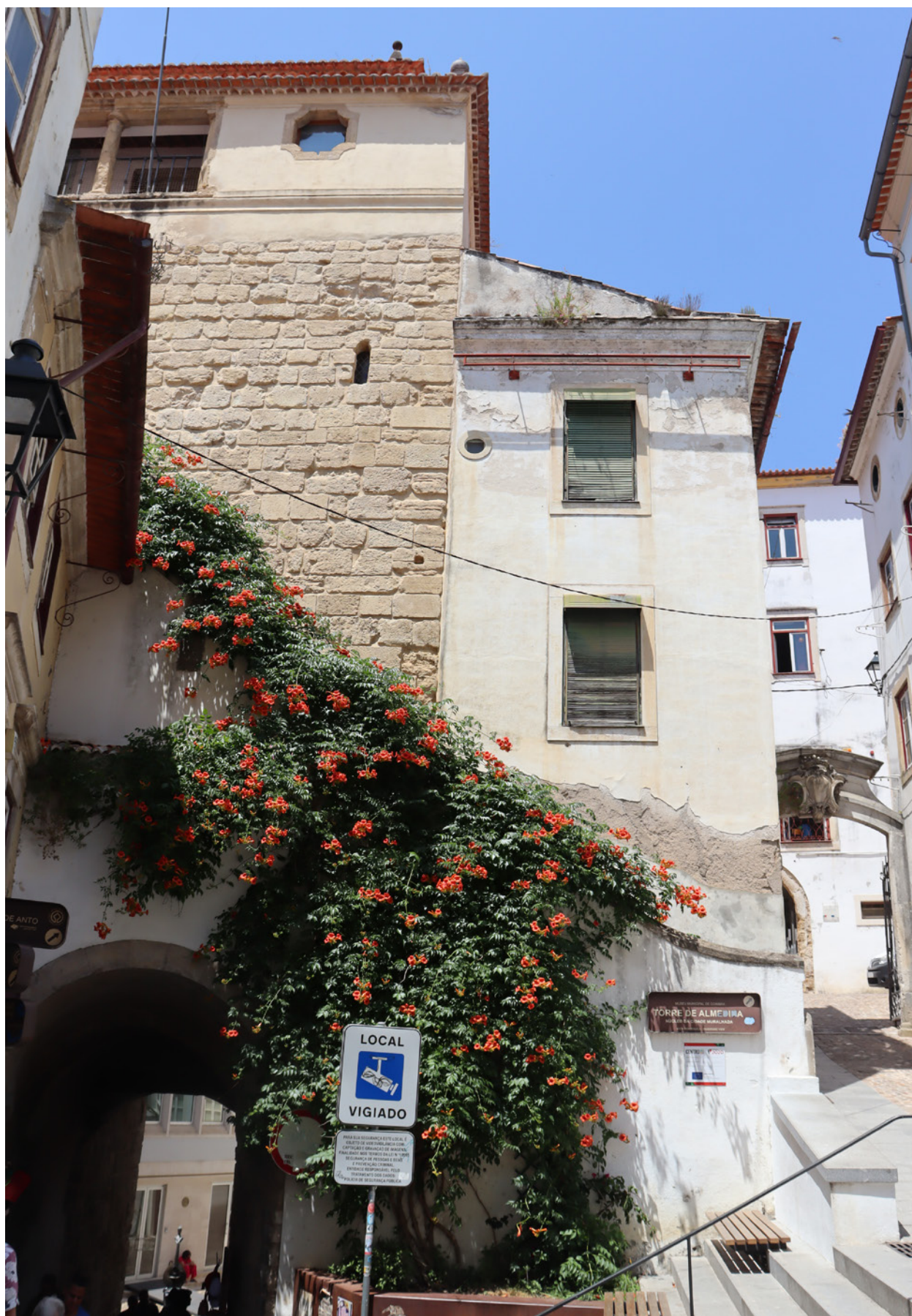
Figura 2 – Edifício n.º 37-39 e o alçado Este da torre de Almedina.
