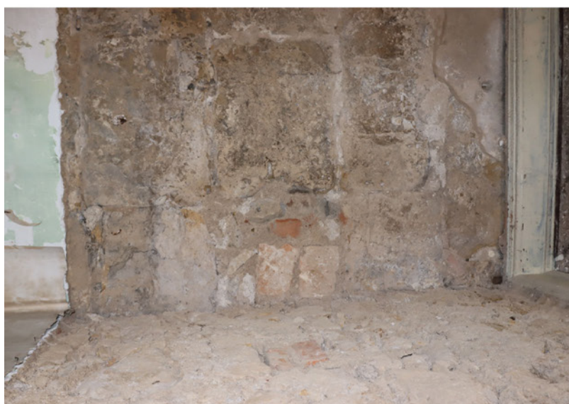
Figura 8 – Paramento da torre com o recorte junto do alçado Sul do edifício.
