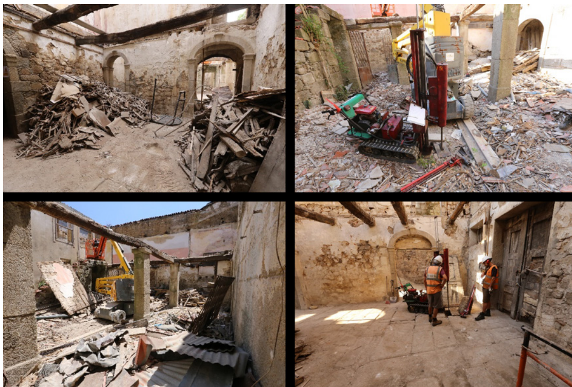
Figura 3 – Registo do acompanhamento dos trabalhos de limpeza, demolição e ensaios geotécnicos © UAUM.
