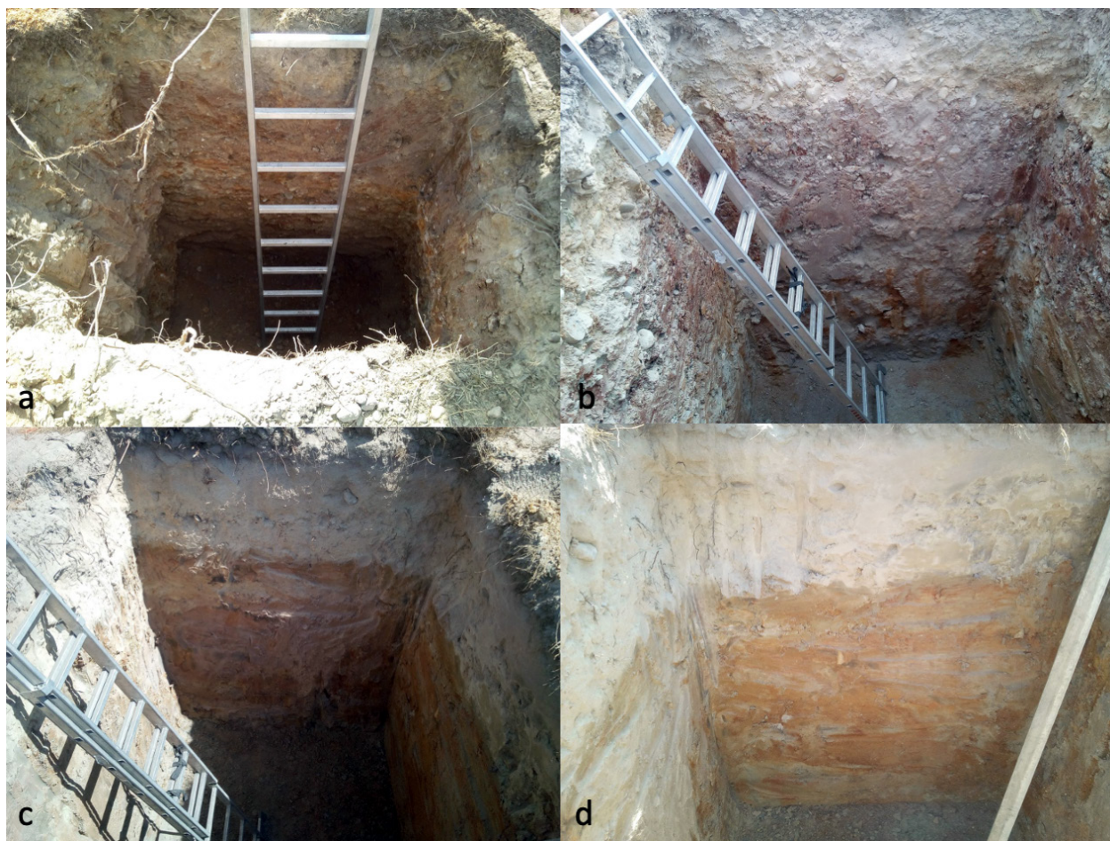
Figura 2 – Aspecto dos trabalhos de escavação em profundidade – a) caixa 2; b) caixa 4; c) e d) caixa 7 (projecto CF GRANHO-19).
