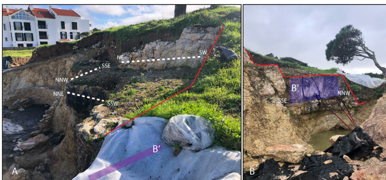
Figura 10 – A: Conjunto de falhas que afecta as camadas geológicas junto ao monumento da Praia das Mações, onde se observa a interrupção e consequente desnível da formação compacta cenomaniana, com indicação da falha B', orientada NNW-SSE. B: Parede B' correspondente ao plano de falha NNW-SSE assinalado na Figura A.
