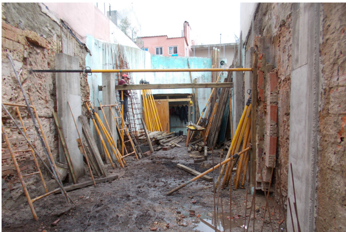
Figura 2 – Vista geral da obra intervencionada.
