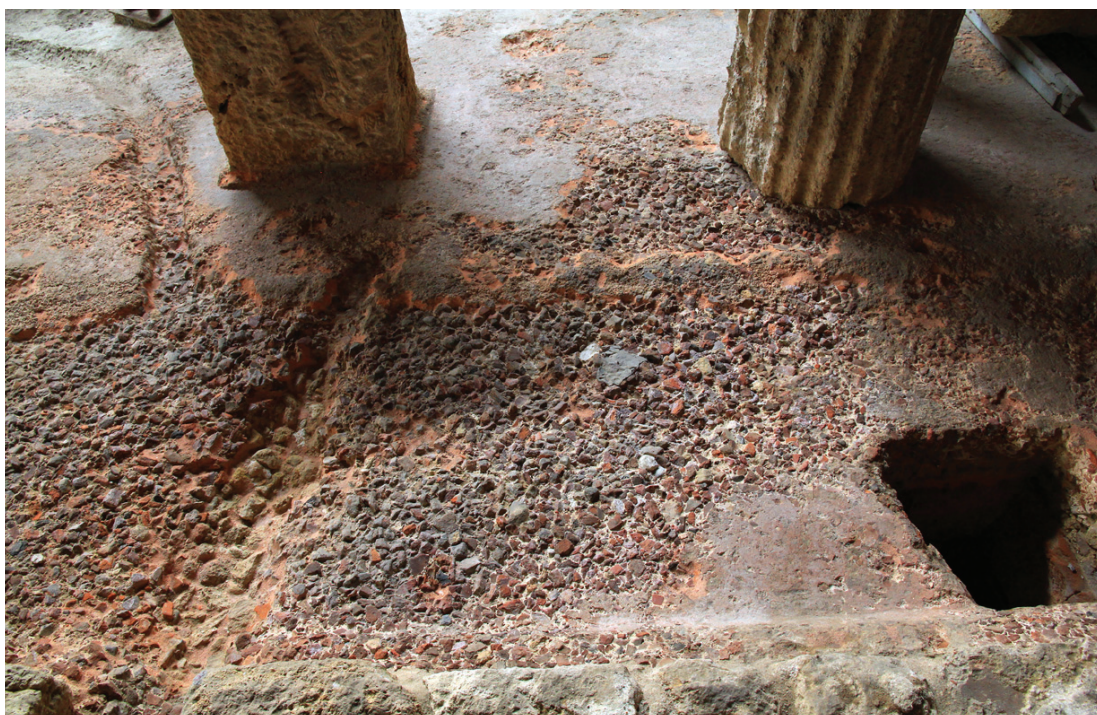
Figura 5 – Aspeto do opus signinum junto ao embasamento da estrutura do proscénio. É visível a constituição interna do pavimento com fragmentos de tijolo, mas, igualmente, a camada de fina argamassa que o recobria. (Fotografia José Avelar / Museu de Lisboa).
