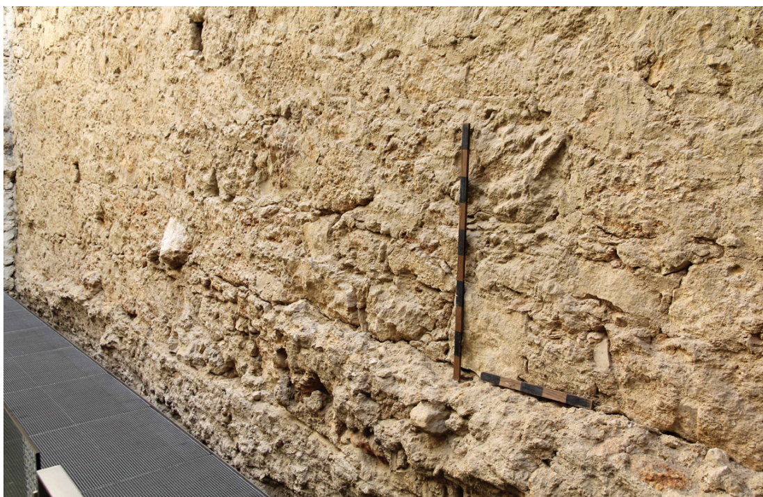
Figura 8 – Estrutura sul de contenção, situada a sul dos post scaenium (atualmente suporta o terraço do museu), observando-se as várias fiadas sobrepostas de opus caementicium . (Fotografia de José Avelar / Museu de Lisboa).
