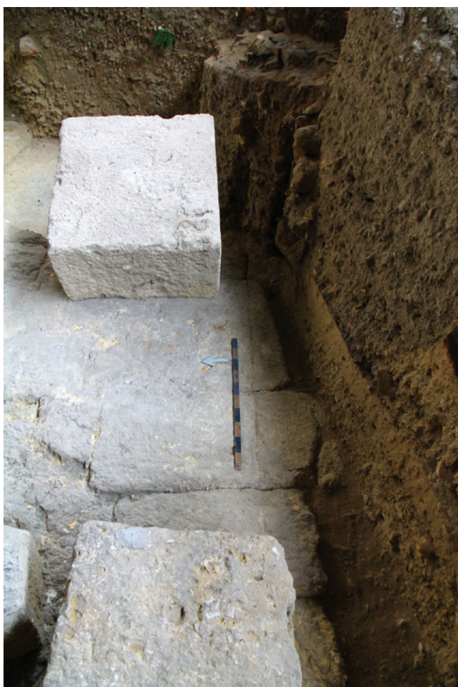
Figura 9 – Perspetiva de ponte para nascente, observando-se, junto à escala, o traçado na rocha (orientação este/oeste), do alinhamento que deveria ser seguido pela fiada de silhares a sobrepor. (Fotografia José Avelar / Museu de Lisboa).
