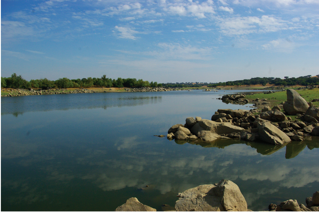
Figura 3 – Vista parcial do Complexo do Pedrogão.
