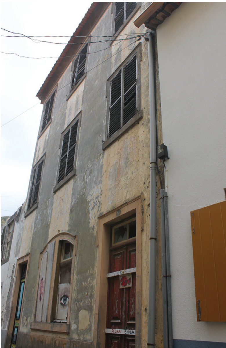
Figura 10 – Casa da Travessa do Mercado (Arquivo CMM).
