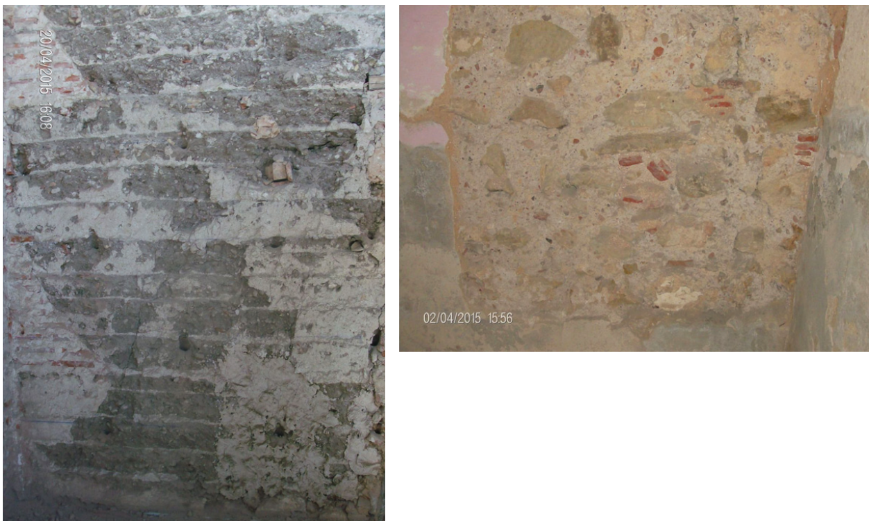
Figura 2 – Pormenores das paredes de taipa e alvenaria de pedra. (autora: Anabela Joaquineto)
