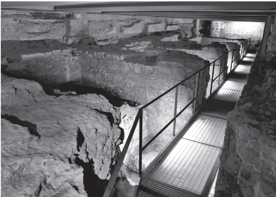
Figura 7 – Em cima, criptopórtico de Augusto que veio a ser integrado no de Cláudio (galeria F). Em baixo, ala sul do criptopórtico. (Fotografias de Danilo Pavone).
