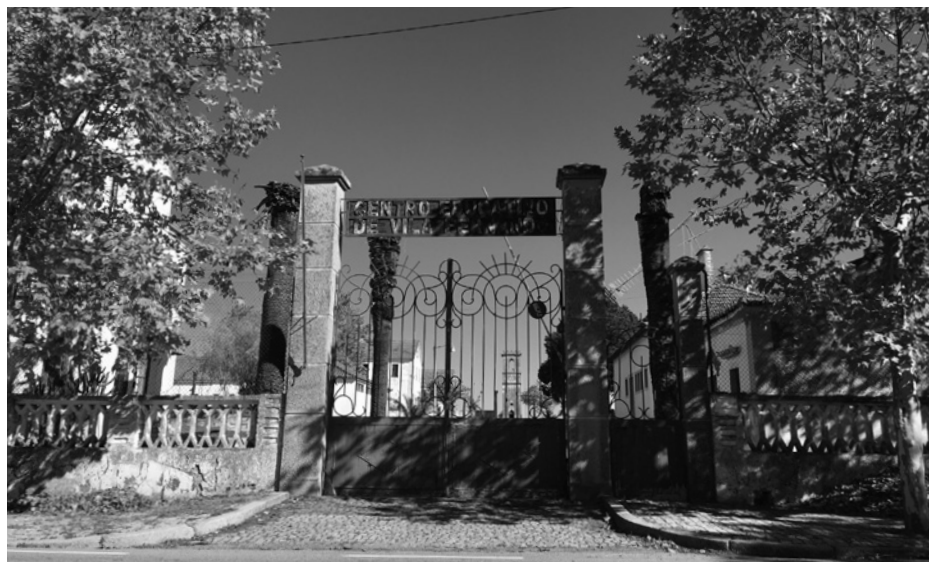
Figura 2 – Vista atual da entrada principal do antigo Centro Educativo de Vila Fernando (Elvas). (Foto da autora)
