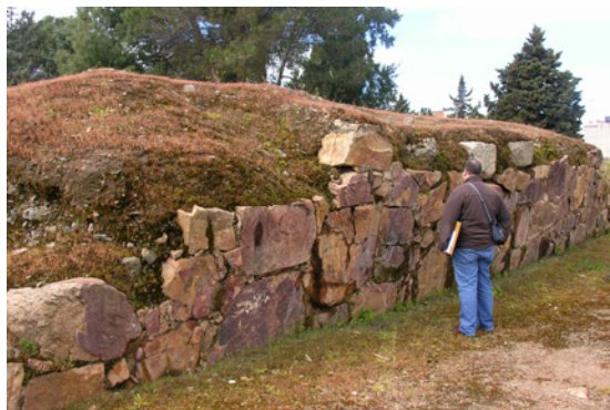
Figura 7 – Paramento de grandes piedras en la zona del Anfiteatro (foto M. Alba).
