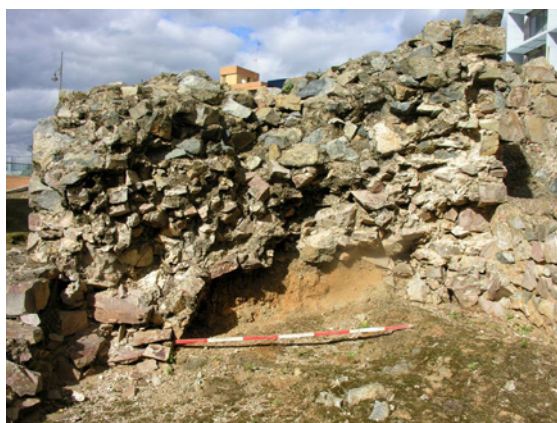
Figura 9 – Sección de la muralla con los paramentos más profundos y un núcleo de piedra troceada predominantemente menuda (foto M. Alba).
