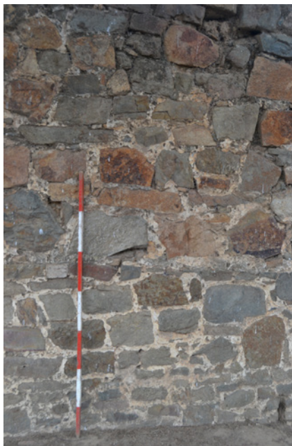
Figura 11 – Aparejos diferentes (ambos augusteos) en la forma de trabajar la piedra y en la forma de colocarla. Prueba de diferentes manos y concepciones en la labor de un mismo lienzo (foto M. Alba).
