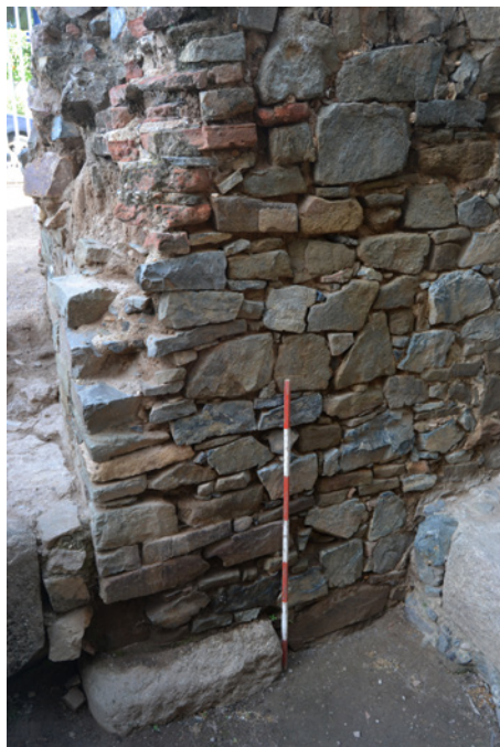
Figura 14 – Jamba de una de las cuatro puertas menores conservadas en Morería. Como paragolpes, en la base llevan una pieza de granito sobresaliente, lateral de mampostería y remate en arco de medio punto con dovelas de ladrillo (foto M. Alba).
