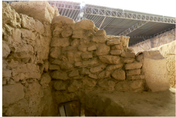
Figura 6 – Pano de muro em “opus mixtum irregular”. Face interna do muro sul do compartimento em análise. (Fotografia de José Avelar – Museu de Lisboa / EGEC).
