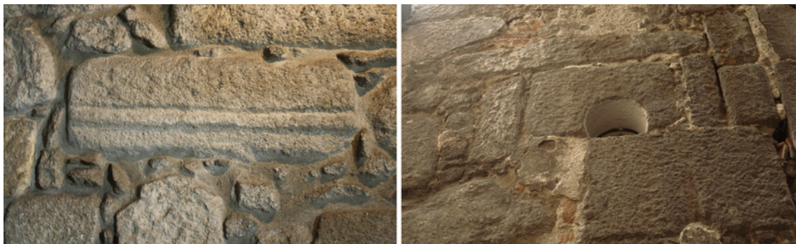
Figuras 10 e 11 – Imposta e fresta com arco em ferradura, identificadas nas imediações da igreja de Miragaia. Fotos: M. Real.
