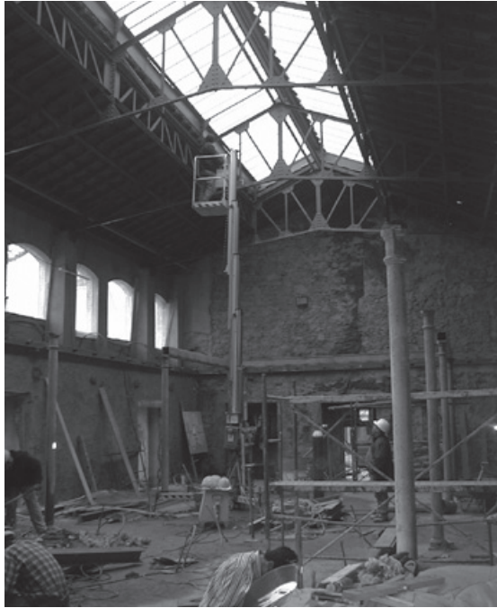
Figura 3 – Aspecto das obras, em 2000, de adaptação do antigo edifício a museu.
