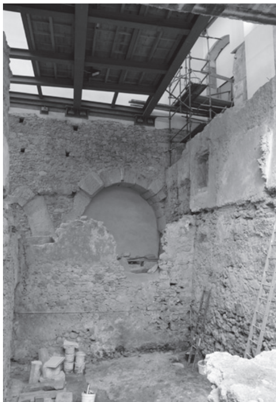
Figura 7 – Antiga habitação dos sécs. XVI/XVII, destruída pelo terramoto de 1755. Perspectiva de nascente para poente e em fase de intervenção. Os arcos, ao fundo, são estruturas de suporte construídas em época pombalina aquando da edificação dos edifícios actuais.
