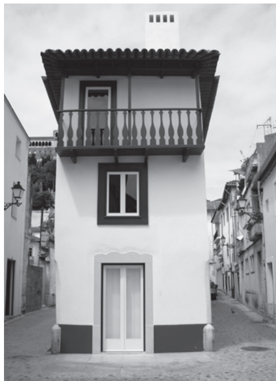
Figura 2 – Fotografia da Casa dos Pintores, datada de 2009, após a conclusão das obras de reabilitação.
