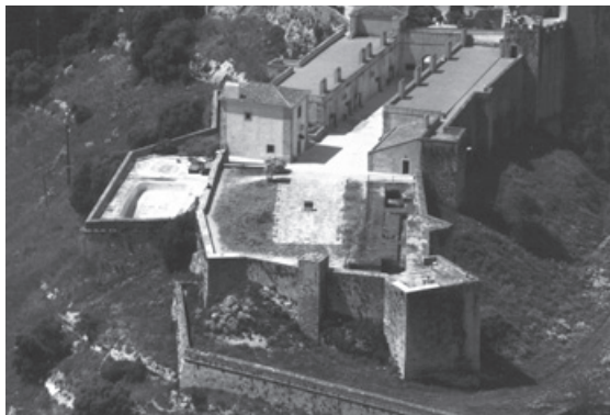
Figura 2 – Muralhas e Praça de Armas vistas de nascente, com escavações arqueológicas em curso.
