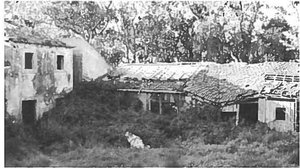
Fig. 6 Edifícios de apoio ao Palácio dos Marqueses de Ponte de Lima. Localizam-se junto ao acesso pedonal do palácio, no lado norte. Os situados em frente foram, entretanto, demolidos pelos serviços camarários. Fonte: Arquivo pessoal Luis Corredoura.
