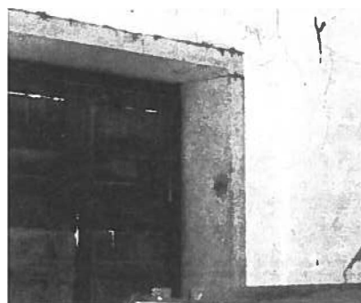
Fig. 20 Pormenor da parede exterior do topo Poente, vista do seu intradorso. É visível a aplicação de alvenaria de tijolos conjuntamente com alvenaria de pedra. Fonte: Arquivo pessoal Luis Corredoura.
