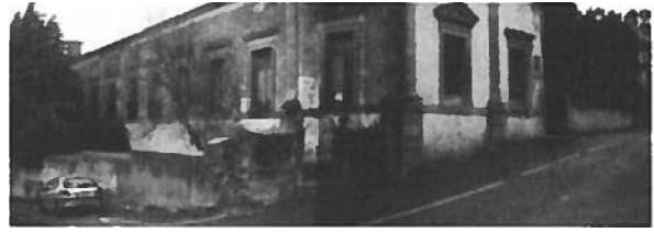
Fig. 5 Fachada sul e nascente do Palácio dos Marqueses de Ponte de Lima. Fonte: Arquivo pessoal Luis Corredoura.
