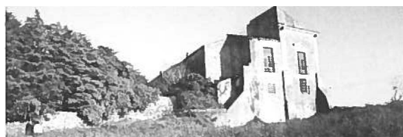
Fig. 10 Topo Poente do Palácio dos Marqueses de Ponte de Lima – Mafra, visto do lado da antiga Quinta da Cerca.. Fonte: Arquivo pessoal Luis Corredoura.
