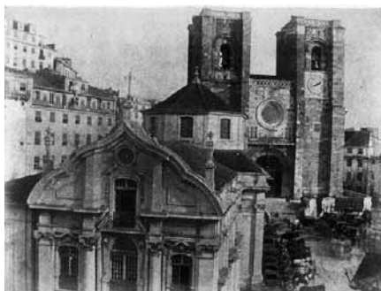
Foto 5 – Igreja da Sé de Lisboa. Sobre o pórtico de entrada são visíveis os vãos e a varanda construídos pelas Obras Públicas à revelia das indicações de Possidónio da Silva. “Revista Pittoresca e Descritiva com Vistas Photographicas”, Lisboa, 1863.
