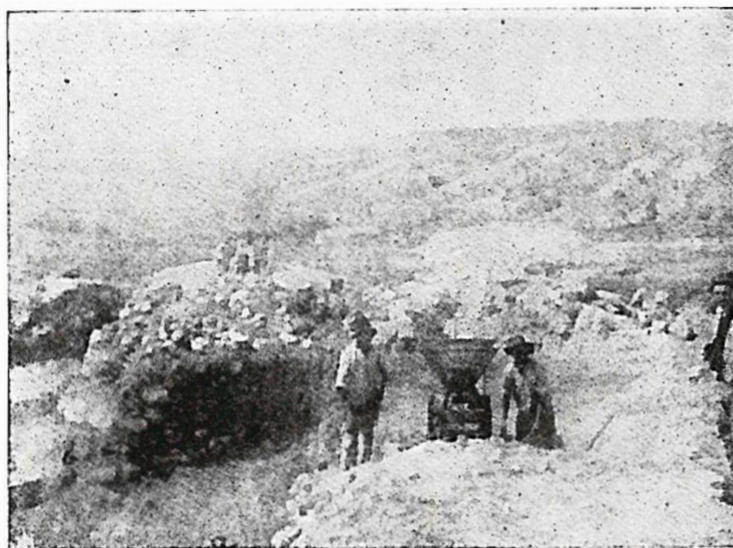
Fig. 11 — Remoção das terras da escavação, do lado Norte. Local da vasilha, a . Começo do muro, b .
