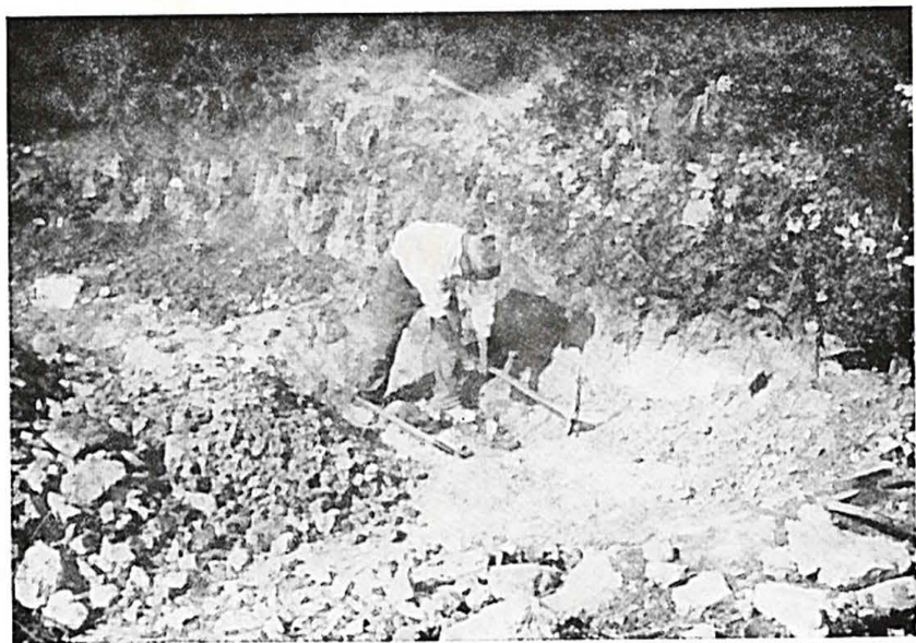
Fig. 6 — Fundo de cabana com pavimento de greda.
