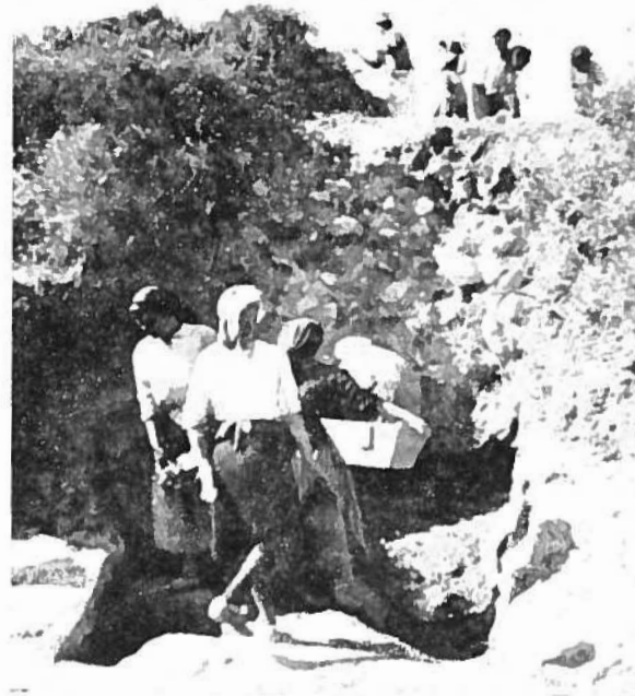
Fig. 10 — Fase adiantada do mesmo trabalho. Vêem-se em baixo pedras de grande tamanho dispostas horizontalmente, servindo de base.
