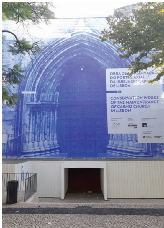
Figura 3 – Entrada do Museu no decorrer das obras.
