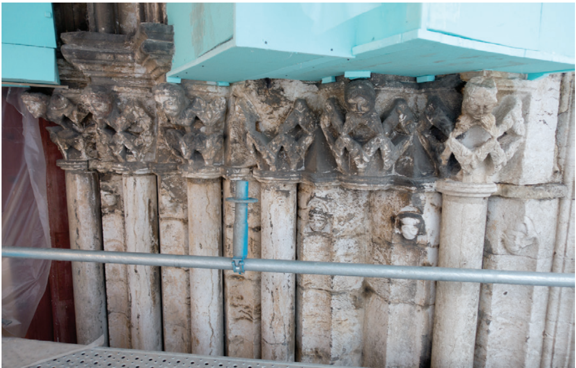
Figura 2 – Limpeza e conservação do Portal Oeste.
