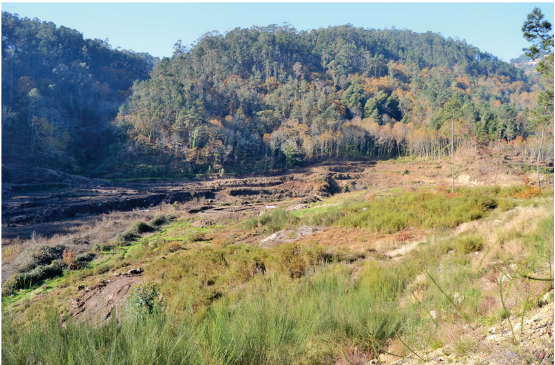
Figura 4 – Vau: vista geral da área de intervenção.
